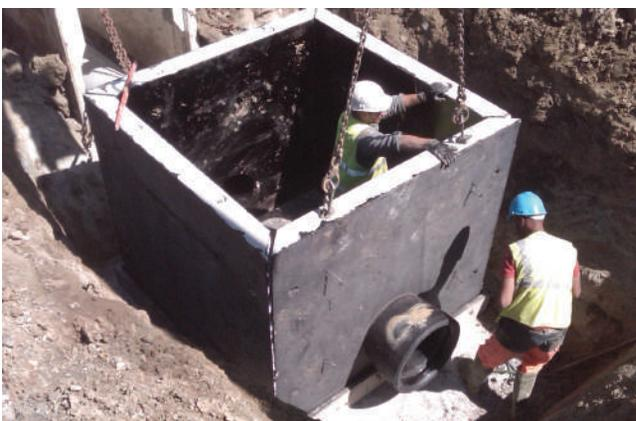
**6** Emboîter le couvercle avec les crochets artéon et vérifier le bon positionnement dans la feuillure.
