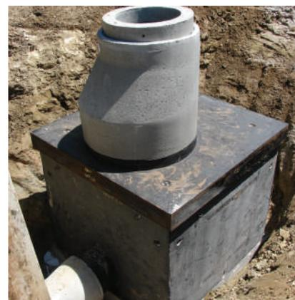
Pour la bonne finition de l'ouvrage jointoyer les angles avec du mastic silicone ou un mortier d'imperméabilisation.
