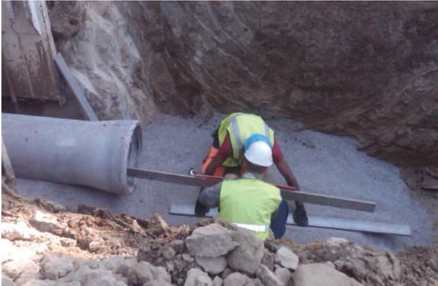
**2** Pose de la dalle à l'aide de crochets artéon. Une fois posée vérifier le niveau, avant de passer à la pose des parois.
