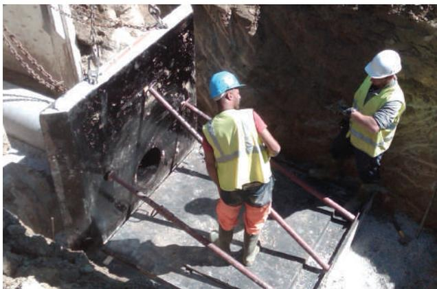
**4** Pose de la seconde paroi : emboîter à nouveau dans l'encoche de la dalle puis boulonner les deux parois entre elles avec les tiges filetées.
